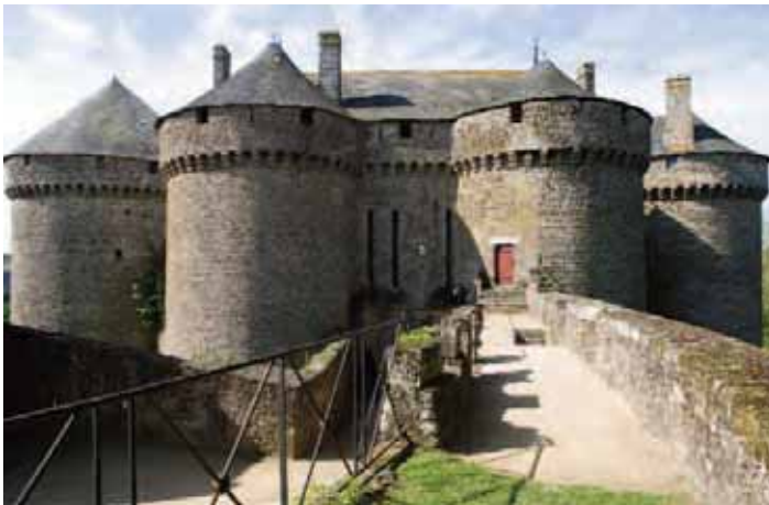
Château de Lassay. La partie habitation vue du boulevard d'artillerie. Le château fut reconstruit après la guerre de Cent ans en une seule campagne de travaux, ainsi que l'atteste l'emploi d'un mortier identique sur l'ensemble du bâtiment et les techniques de mise en oeuvre de la maçonnerie.
