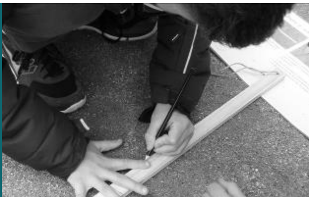
← Réalisation de la pige.
