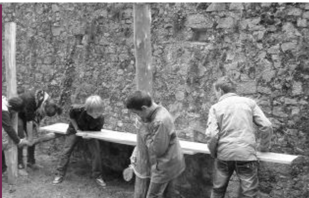
← Montage de l'échafaudage.
