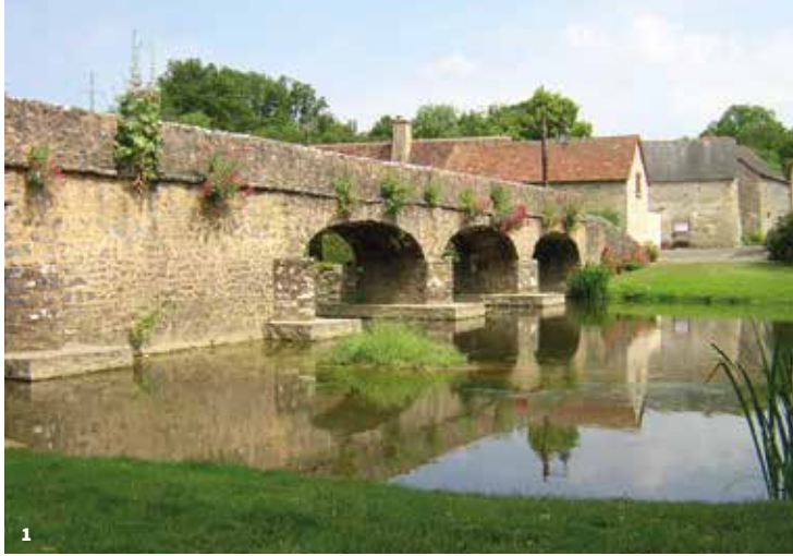
1. Le pont piéton © PAH
